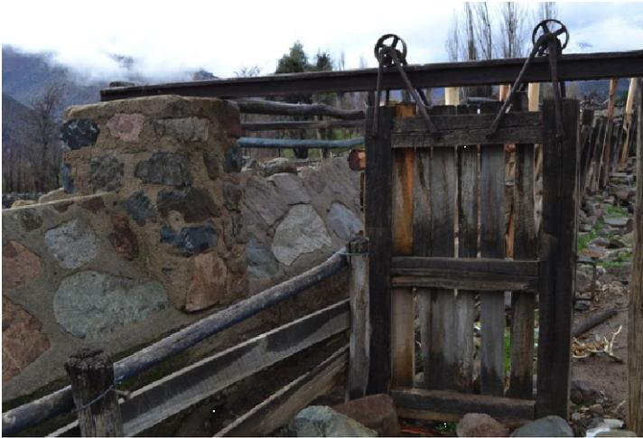
Detalle del muro de hormigón, piedra con puerta metálica y guías superiores para controlar el paso de animales.
