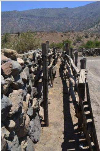
Detalle del callejón o chiquero compuesto por la pirka de piedra y una cerca de madera en base a cuartones.
